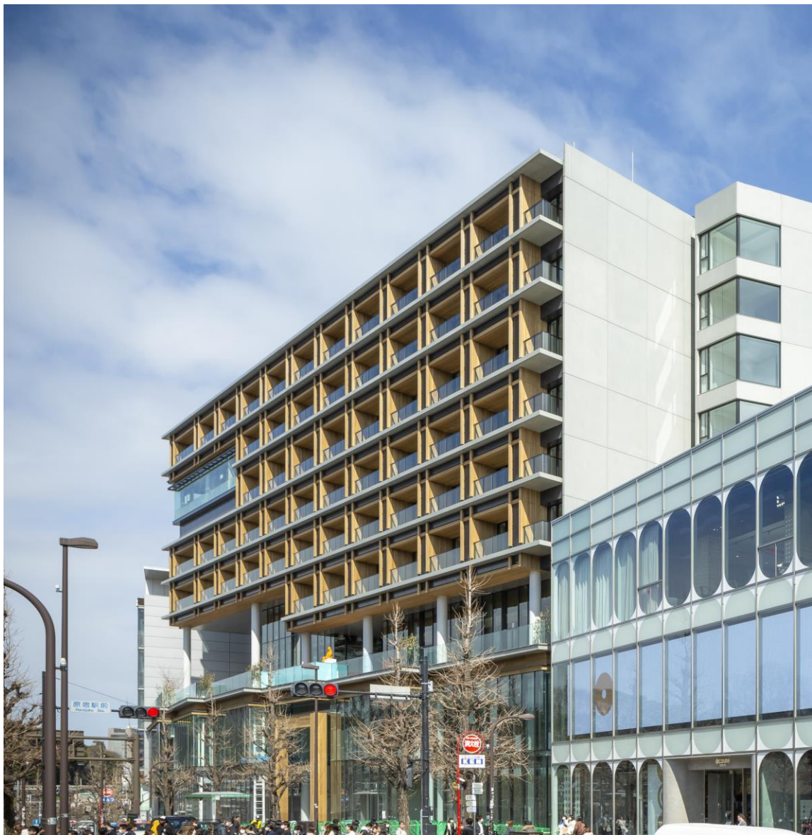
原宿駅側外観（南側） ※
