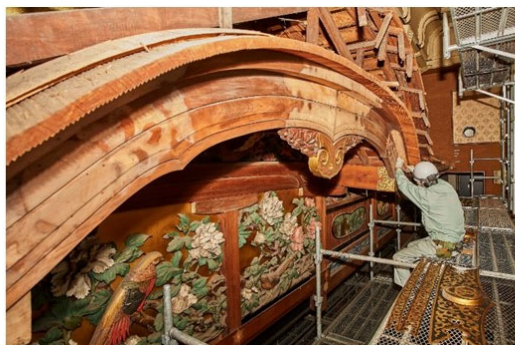
舞台上部の唐破風を手作業で丁寧に取りほどく様子
