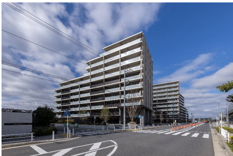
「グレースィアウエリス横浜ゆめが丘」の外観
