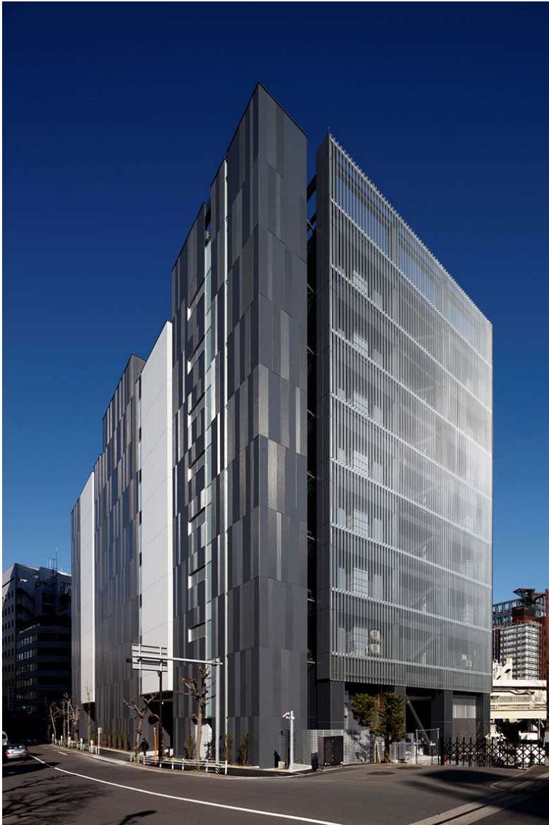
陽の当たり方で表情が変わる南面外壁と金属ルーバーに覆われた東面設備バルコニー
